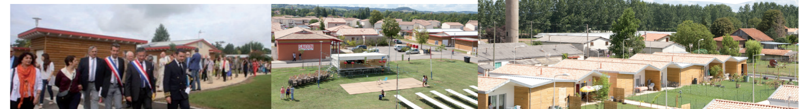
La délégation officielle a continué son périple à pied sur le site par la visite des nouveaux logements, des aménagements extérieurs. Ces nouveaux logements vus ensuite d'en haut.
